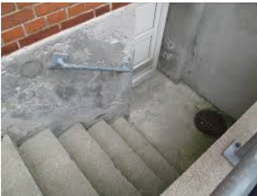
Kælderskakt med afløb for regnvand
