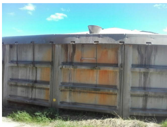
Figur 3.9: Efterlagertank.
