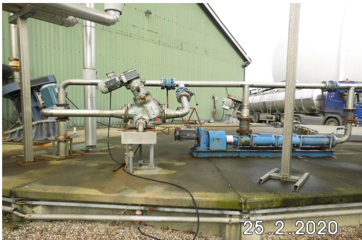
Figur 10.5: Eksempel på fritliggende rørføringer - her på befæstet areal, hvor vandet løber til tank og benyttes i produktionen.
