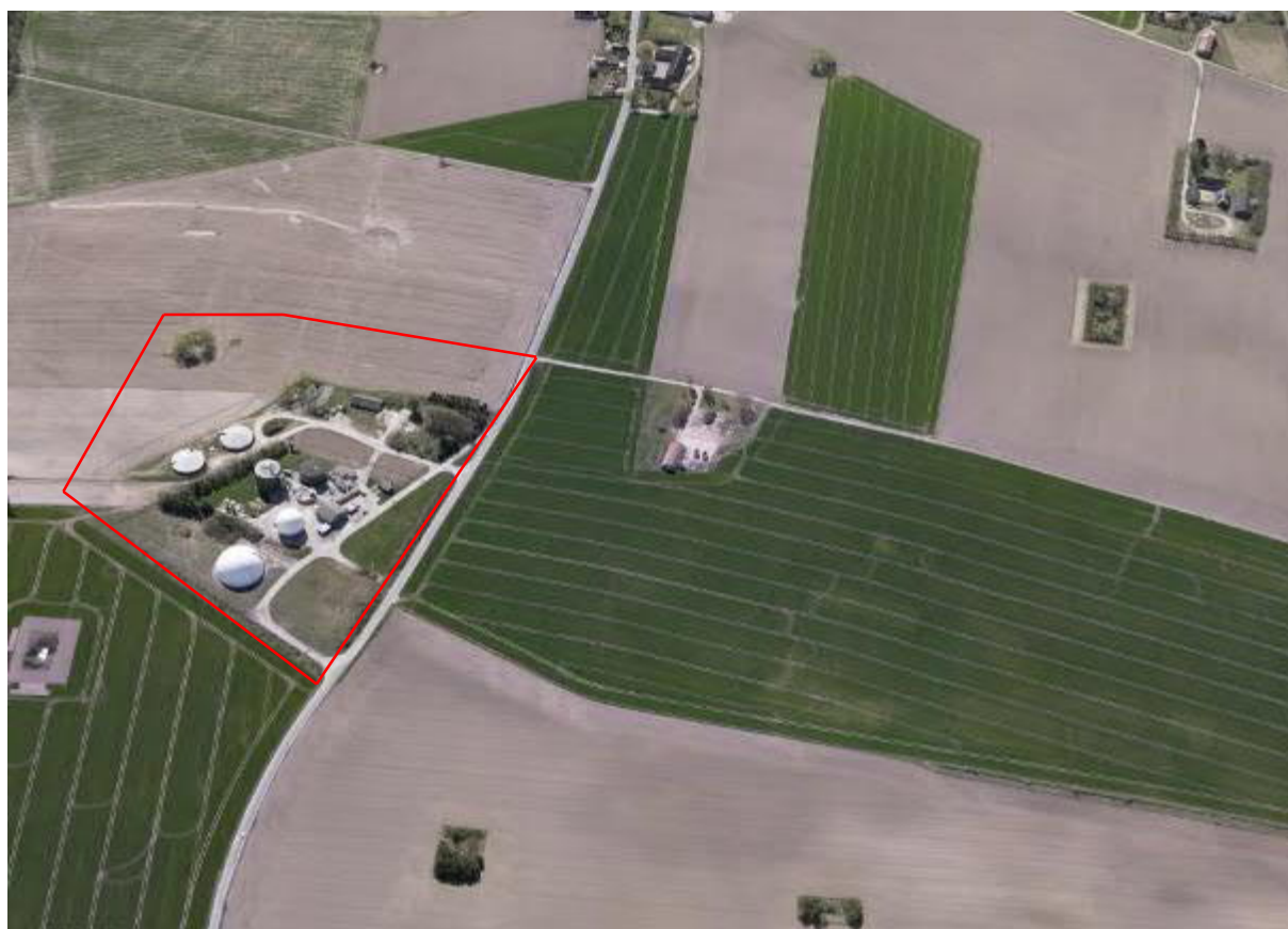
Figur 18.1: Skråfoto af eksisterende anlæg med angivelse af lokalplanområde 139.
