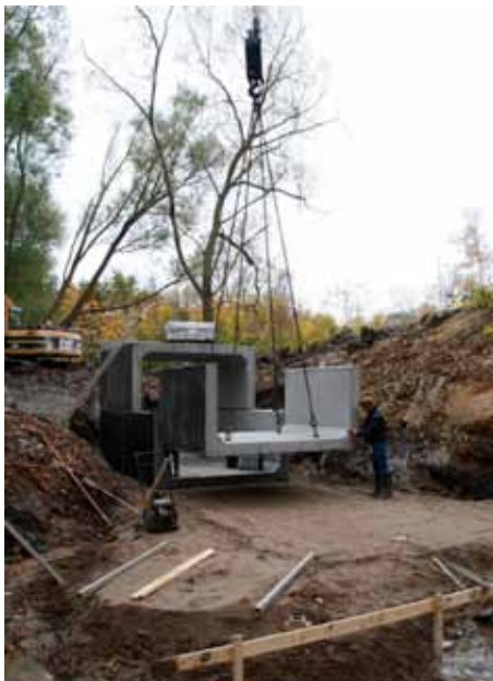
Ny tunnelbro (28. oktober 2009).
