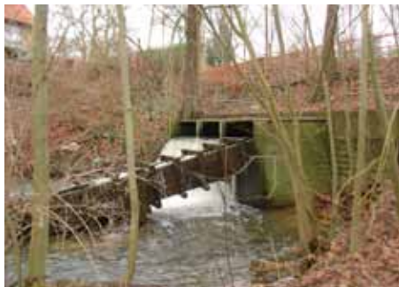
Fisketrappen umiddelbart inden nedrivning.
