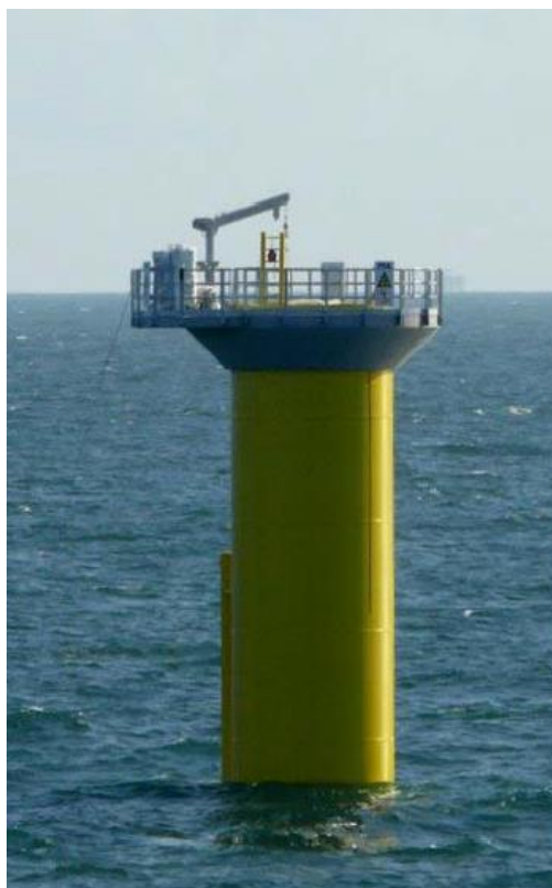
Figur 5.4.1 Monopæl med overgangsstykke, hvorpå platform, landgang mm. er monteret. (Energinet.dk).
