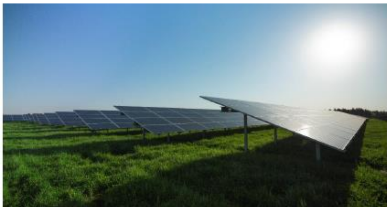
Princip for opstilling af solcellepaneler på terræn. Solcellerne antirefleksbehandles.
