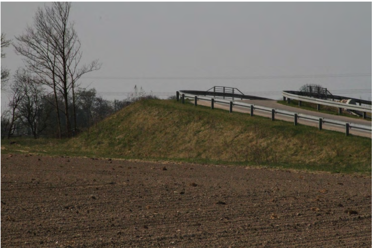
Sydvendt vejdæmning ved vejbro over jernbanen v. Valbygård.
