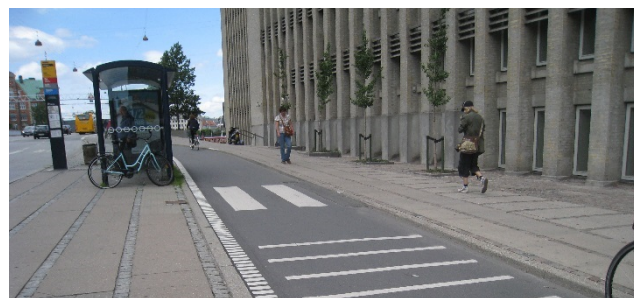
Foto 55: Asfaltrampe på cykelsti ved midterdør til bus.
