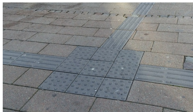
Foto 52: Opmærksomhedsfelt ved retningsskift.
