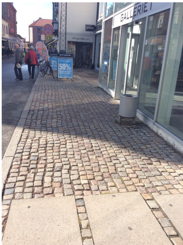
Foto 29: Utlægning af gangbane, med brosten og inventar
