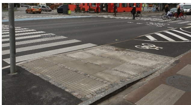
Foto 46: Tilgængelig helle med to-delt løsning med opspring og retningsfelt for synshandicappede og nedsænket kantsten for kørestolsbrugere.
