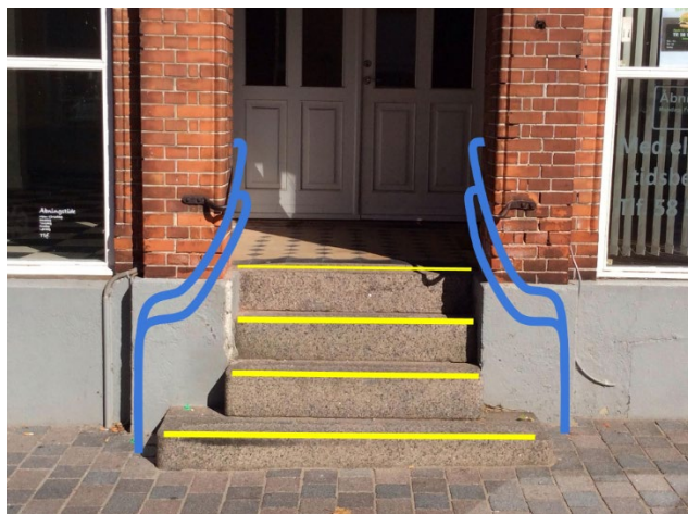
Illustration 6: Gelænder på trappe og markering af trinforkanter
