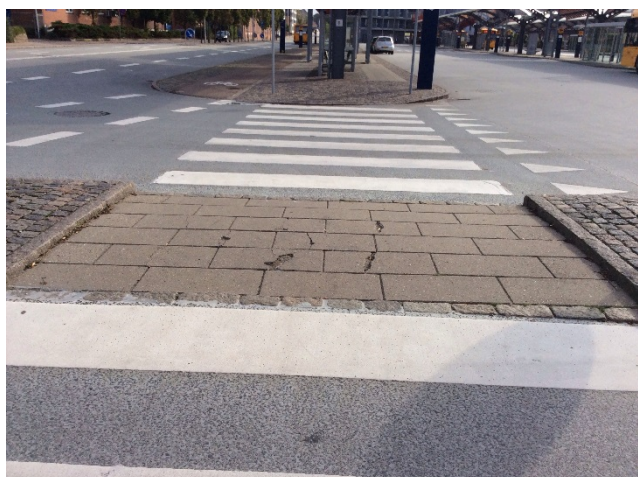
Foto 30: Utlægning af helle
