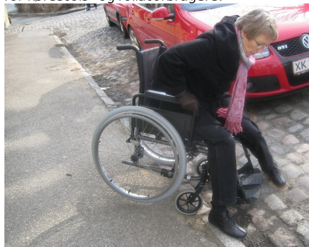
Foto 49: Kørestolsbruger, der er kørt af gangbane pga. for stejlt tværfald.
