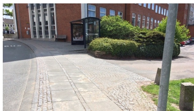
Foto 11: Brostenoverkørsel med gennemført fortov ved Rådhuspladsen i Slagelse.
