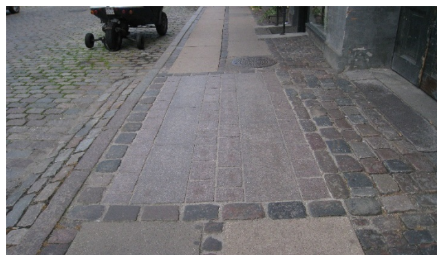
Foto 53: Jævn gangbane i brostenoverkørsel.
