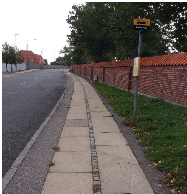
Foto 32: Busstoppested mangler opmærksomhedsfelt og retningsfelt
