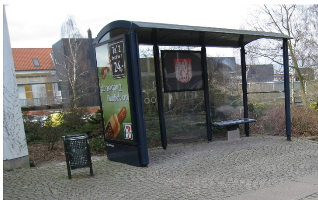
Figur 11: Læskærm ved busstoppested i Slagelse. Der mangler jævn belægning og ryg/armlæn på bæk.
