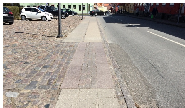
Foto 12: Brostenoverkørsel med gangbane i bordursten og savede og jetbrændte brosten i Skælskør
