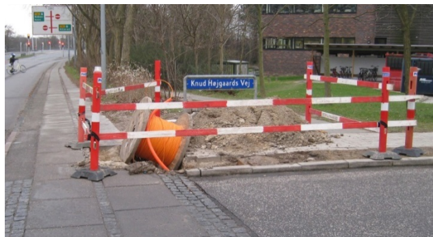
Foto 62: Korrekt opsat afspærring ved vejarbejde.
