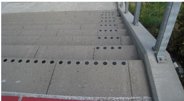
Foto 60: Markerings af trinfor kanter på trapper.
