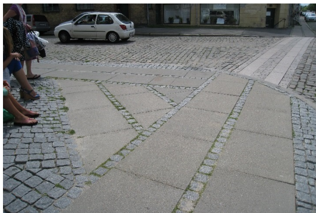
Foto 45: Korrekt anlagt fortov ved hjørne.
