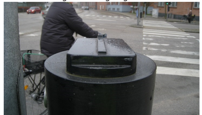
Foto 44: Akustisk signal hvor retningsgiveren peger i den forkerte retning.
