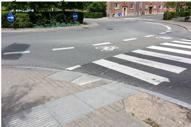
Foto 42: Retningsfelt og opmærksomhedsfelt ved fodgængerovergang i rundkørsel.
